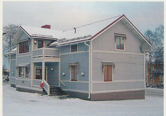
Ekfors Krafts kontor i Övertorneå
