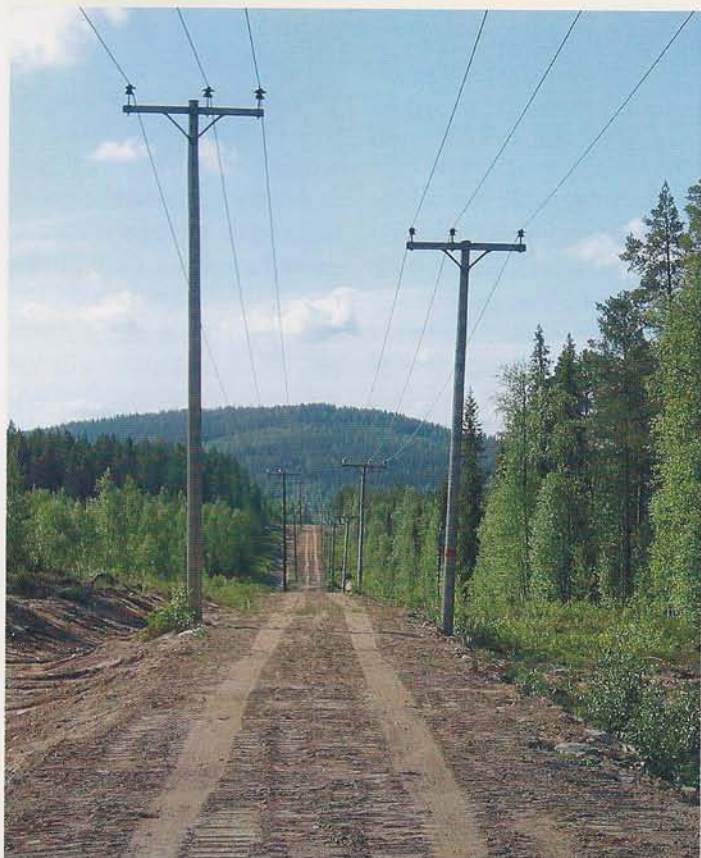
Ekfors 20 kv ledningar. Vål röjt, med breda ledningsgator och på många ställen, framkomligt med bil.
